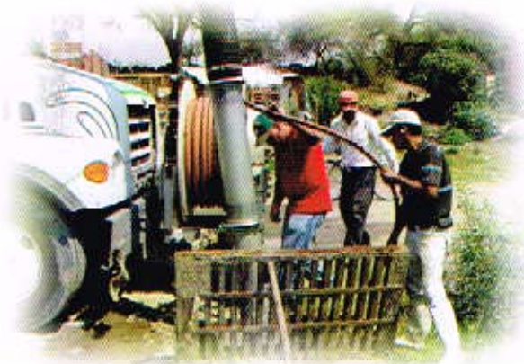
Mantenimiento e instalación de equipos de rebombeo en:)
